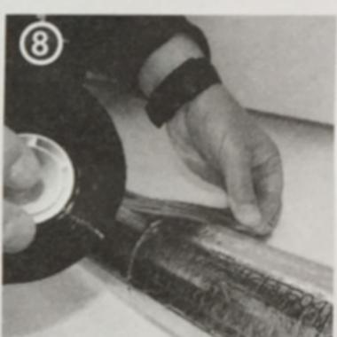
Querstöße der Schalen sind fugenfrei zu verlegen und zusätzlich mit geeignetem Klebeband des Herstellers zu sichern.
