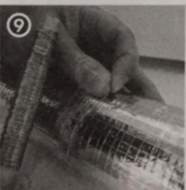
Empfohlen wird die zusätzliche Sicherung der **Steinwolle Isolierschale Alu** mit **weichverzinktem Bindedraht**. <sup>2)</sup>
